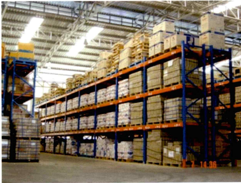
Figure 22 : Exemple de rayonnage simple profondeur
